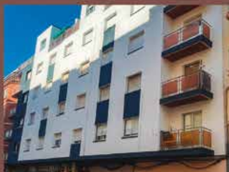
RENOVACIÓN DE FACHADA EN CALLE TERREL, SORIA
